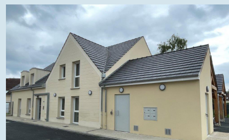
14 logements à Trosly-Breuil
